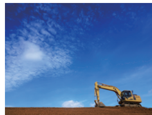
土木工事・測量
